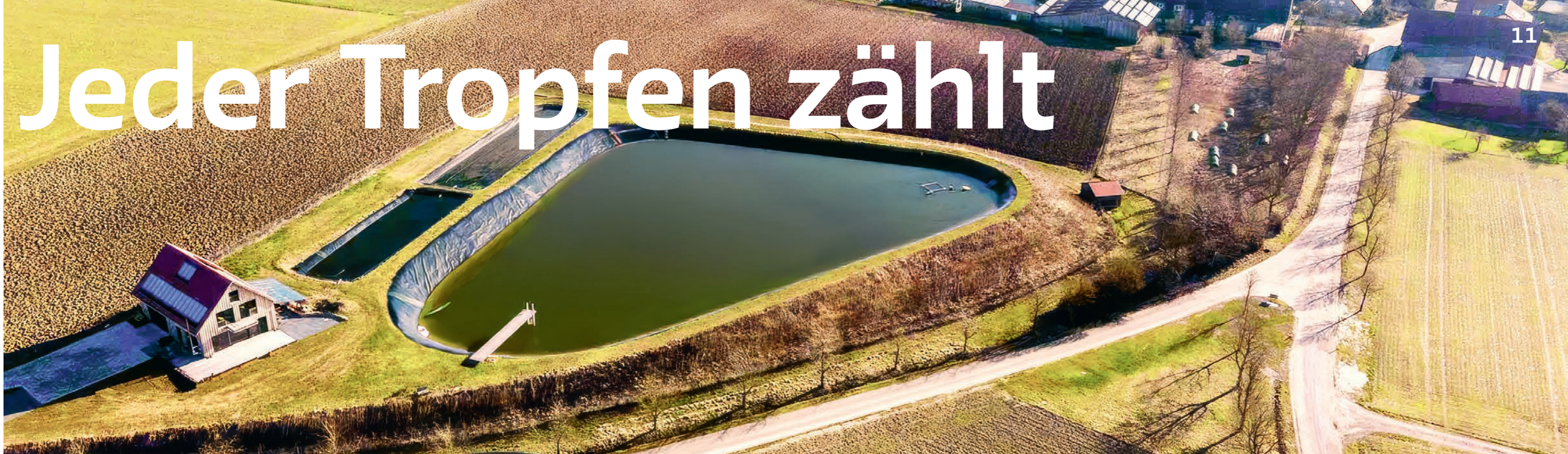
Die ehemalige Jauchegrube hat Landwirt Hartmut Engelhardt zum Wasserspeicher umfunktioniert.
