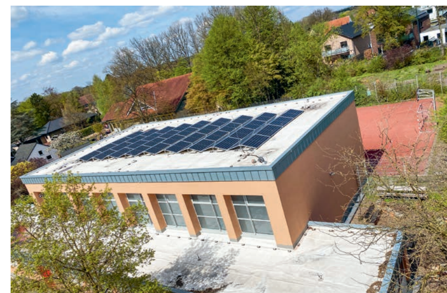
Neben einer Photovoltaikanlage auf dem Dach wurden zahlreiche weitere energetische Maßnahmen umgesetzt.
